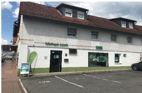
Abbildung 2 | Dienstleistungen an der Darmstädter Straße (Quelle: DSK)
