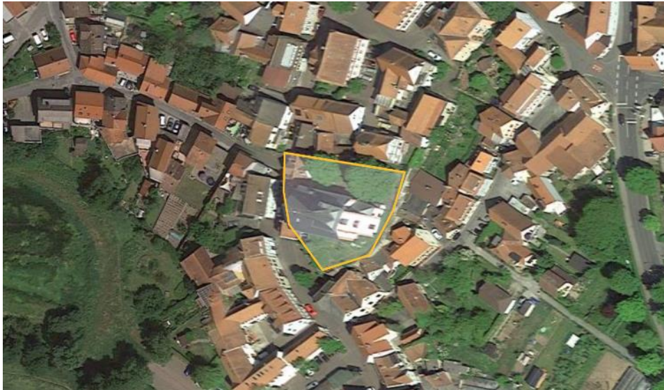
Abbildung 36 | Michaelskirche und Kirchgarten im nördlichen Fördergebiet
