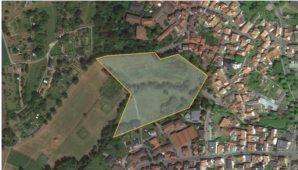
Abbildung 48 | Mergbachaue im westlichen Fördergebiet
