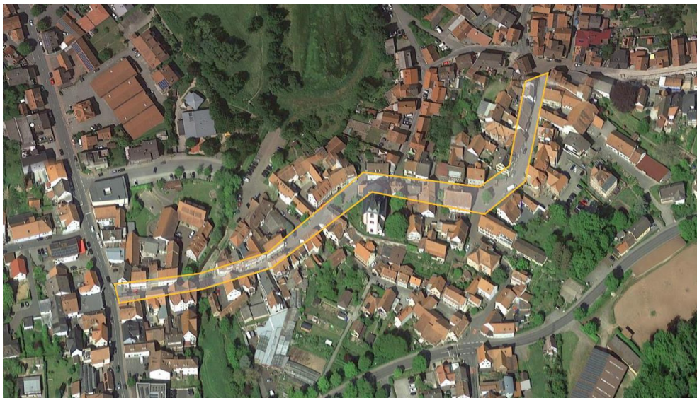
Abbildung 32 | Bismarckstraße im zentralen Fördergebiet
