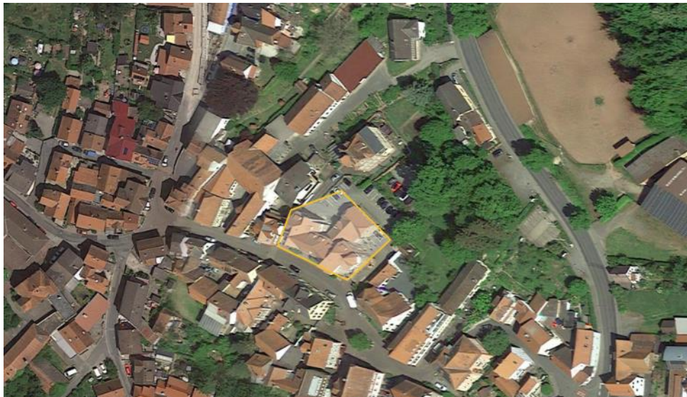
Abbildung 49 | Rathaus der Gemeinde Reichelsheim im nördlichen Fördergebiet
