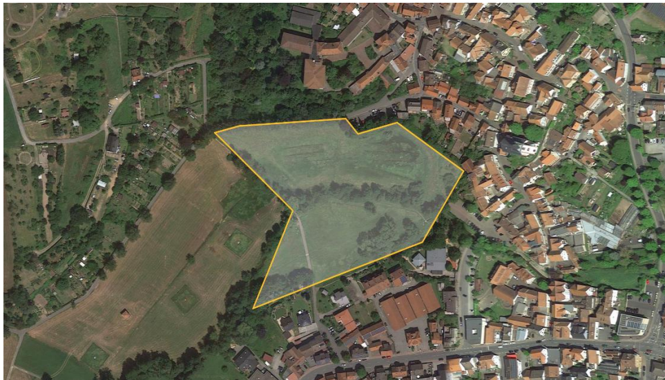
Abbildung 46 | Mergbachaue im westlichen Fördergebiet
