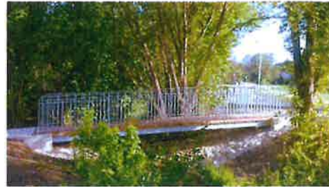
Abbildung 44: Beispiel einer barrierefreien Fußgängerbrücke in Käuelkofen (Bayern)
