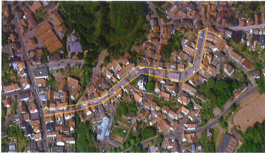
Abbildung 32 | Bismarckstraße im zentralen Fördergebiet
